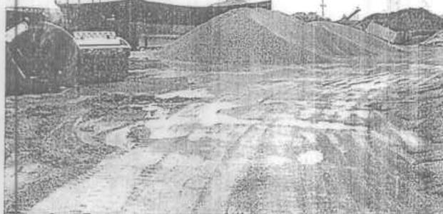
*Foto 11. Acumulación evidente de cuerpos de agua al interior de la planta debidos a las lluvias.*
